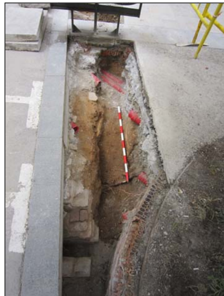
FOTO 24. Tram 2: En primer terme, canalització ue-13, seguidament el paviment ue-2031, i el mur ue 2022. A continuació, els nous estrats i paviments.
