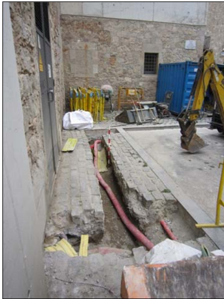
FOTO 1. Vista de la rasa un cop excavada (Tram 1).
