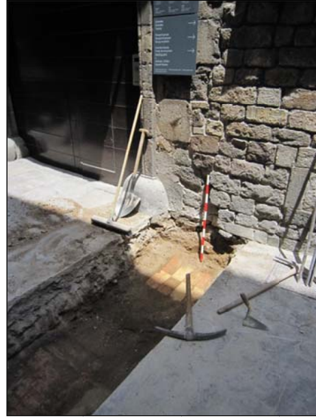
FOTO 14. Treballs d'excavació manual de la rasa al Tram 5.
