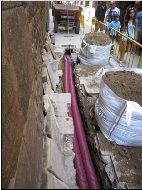
FOTO 21. Vista de la rasa al tram 6.
