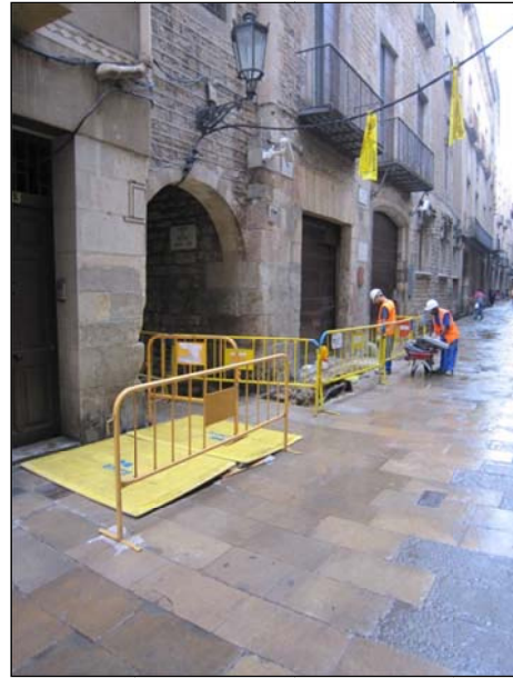
FOTO 10. Vista de la rasa al tram 4, a la cantonada amb el carrer de Montcada.
