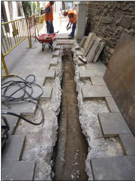
FOTO 5. Vista de la rasa al tram 3, a l'inici del carrer de Cremat Gran.
