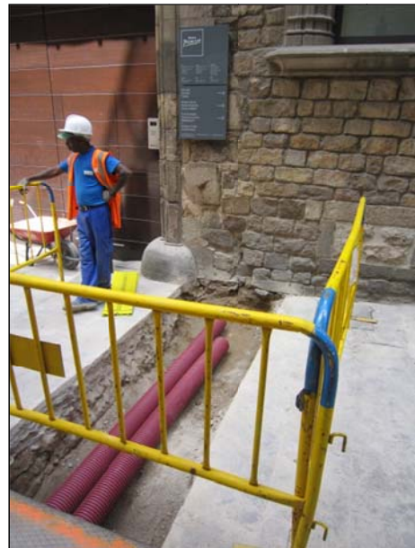
FOTO 16. Vista de la rasa al creuament del carrer Montcada amb la col·locació dels nous tubs.
