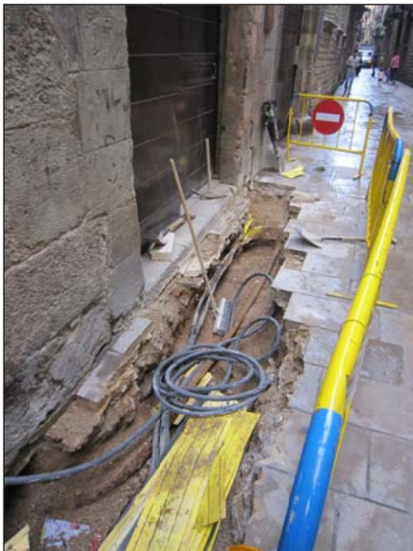
FOTO 11. Rasa a mig del tram 4 on s'observa la gran quantitat de cables al seu pas.
