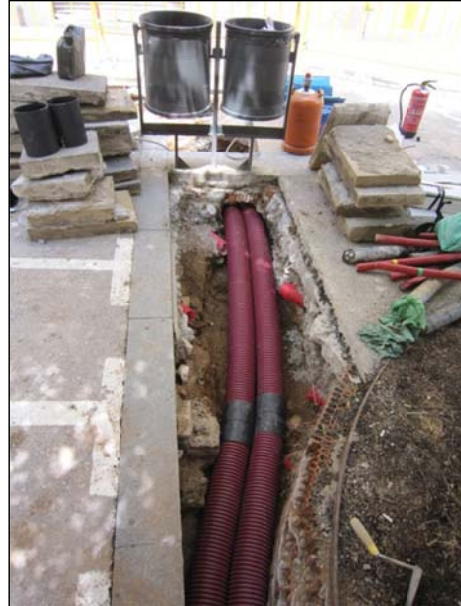
FOTO 28. Vista de la col·locació definitiva dels nous tubs.
