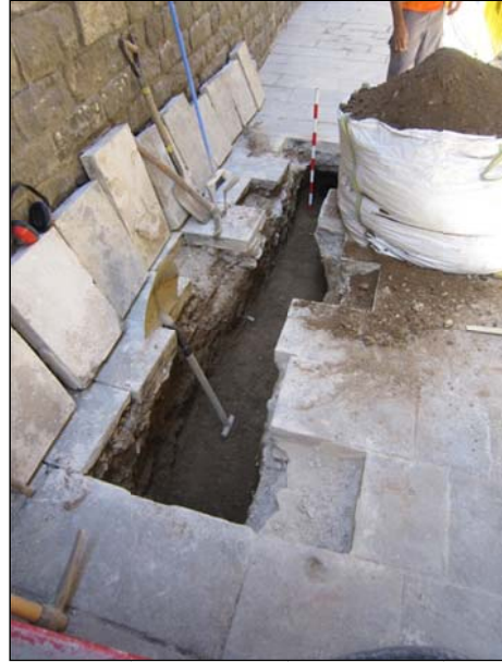
FOTO 18. Vista de la rasa al tram 6.
