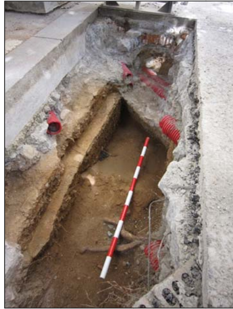
FOTO 26. Detall dels nivells de paviment ue-02 i ue-04.
