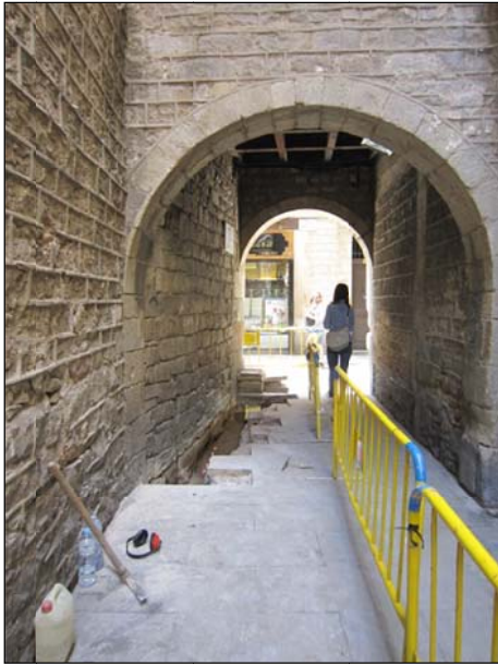
FOTO 9. Vista de la rasa al tram 3, al pas per sota del porxo del carrer de Cremat Gran.
