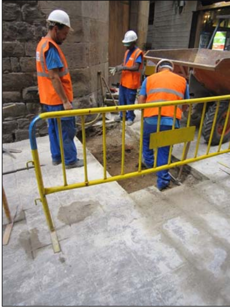
FOTO 13. Treballs d'excavació manual de la rasa al Tram 5.
