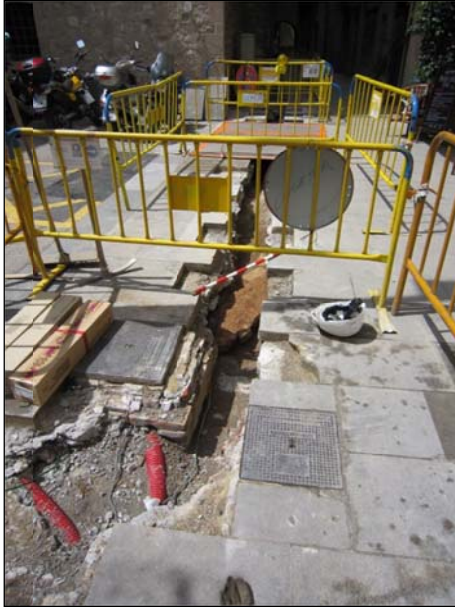
FOTO 29. Vista del mur ue-17 aparegut a l'inici del tram 3.
