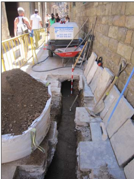
FOTO 19. Vista de la rasa al tram 6.
