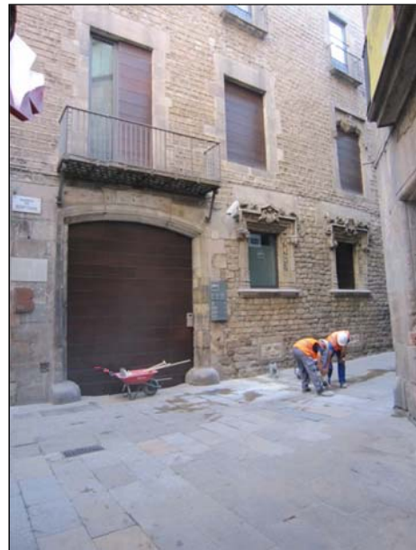
FOTO 12. Vista de l'inici d'obertura del creuament de la rasa (tram 5) a al carrer de Montcada a la confluència amb el carrer de la Barra de Ferro.
