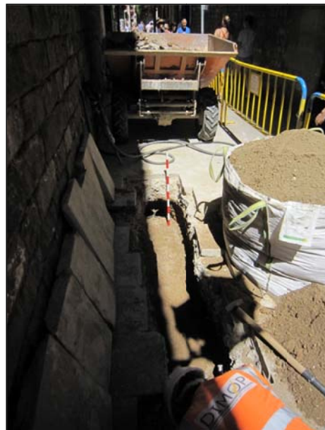
FOTO 20. Vista de la rasa al tram 6.
