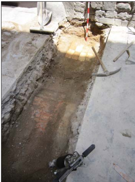
FOTO 15. Vista de la rasa al creuament del carrer Montcada. Aparició del col·lector principal del carrer.
