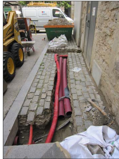
FOTO 2. Vista de la rasa amb la col·locació dels nous tubs (Tram 1).
